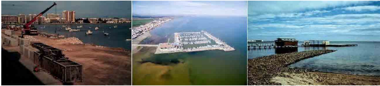
Figura 2.5. Las obras costeras han sido uno de los problemas graves del Mar menor en las últimas décadas. El relleno de terrenos ganados al mar, la construcción de diques y puertos deportivos y la creación de playas artificiales han disminuido su superficie y profundidad, acelerado su colmatación, alterado las corrientes y provocado enfangamientos y turbidez.
