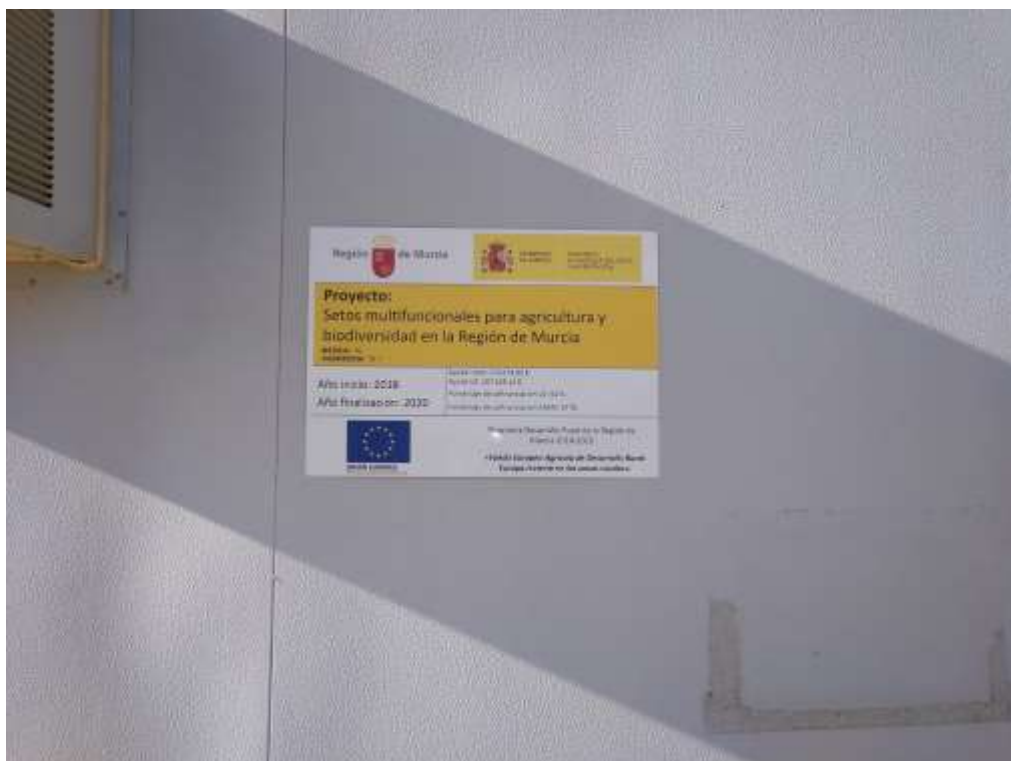
Foto 19. Cartel instalado en García Vargas.
