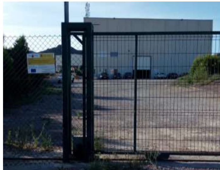
Foto 17. Cartel instalado en CR Arcosur
