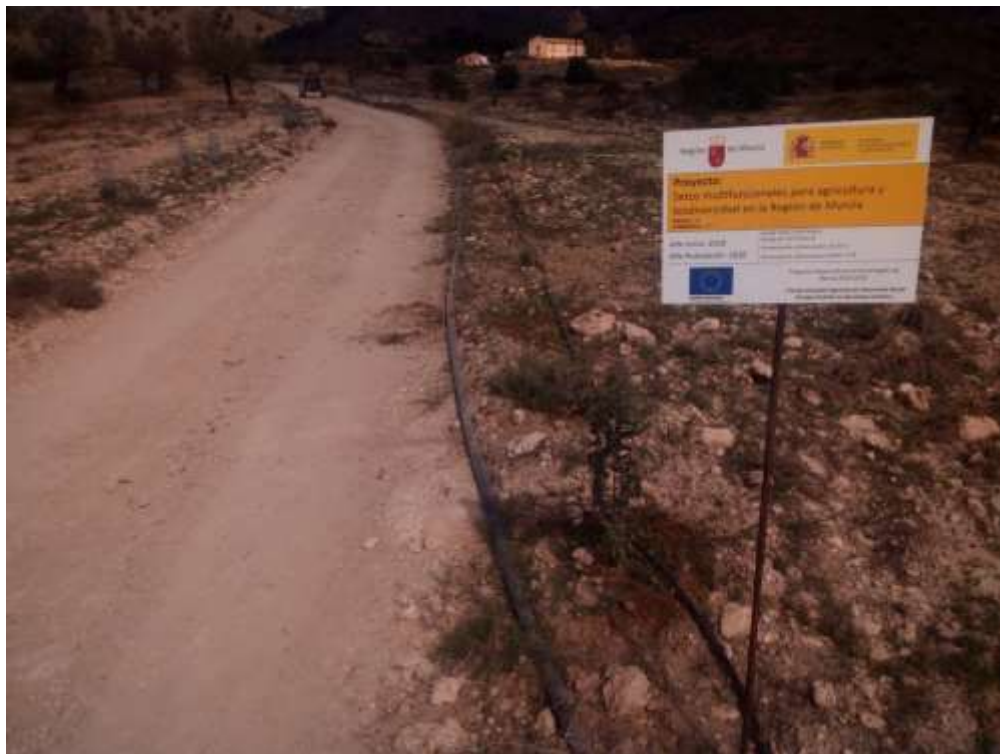
Foto 21. Cartel instalado en Aguilas (Ecotalayon y Castillo de Chuecos)
